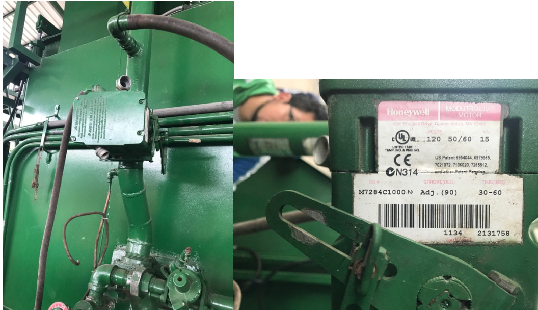
Figura 17. Modutrol IV Motor cámara primaria.
