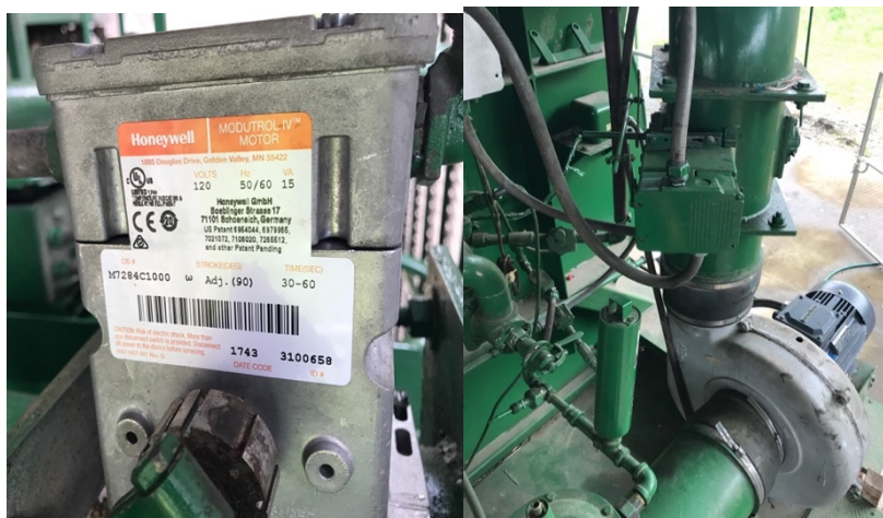
Figura 31. Modutrol IV motor cámara secundaria
