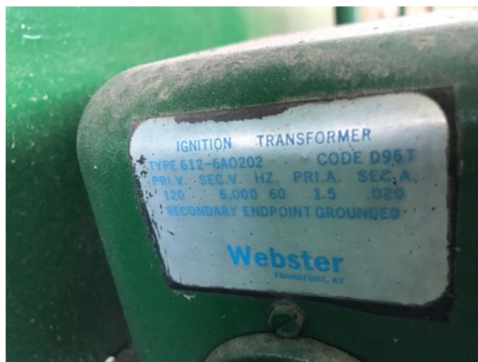
Figura 15. Chispa de ignición cámara primaria
