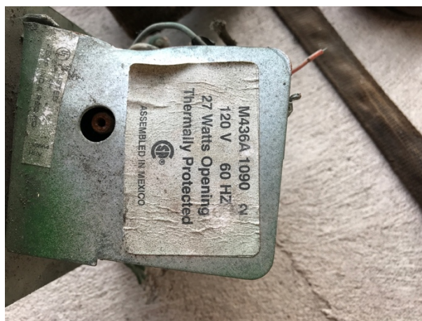
Figura 23. Dámper control de aire.
