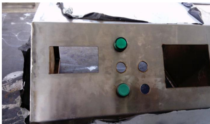
Figura 103: Colocación de elementos de mando y control
