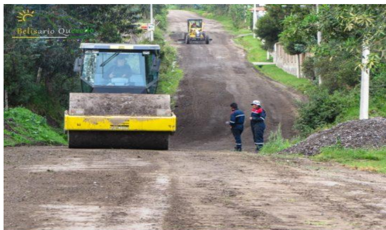
Figura 59. Asfaltado de carreteras
