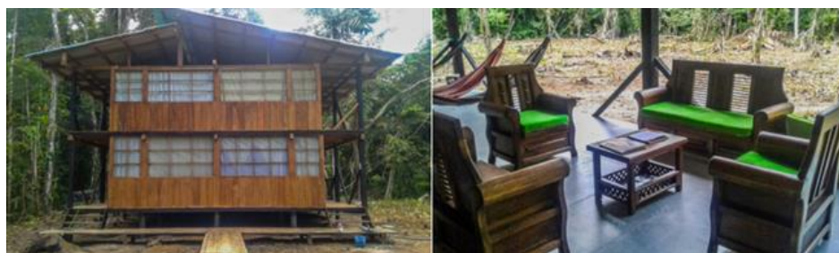
Figura 28. Instalaciones Conangueno lodge Fuente: (Conangueno Lodge Cuyabeno, 2018)
