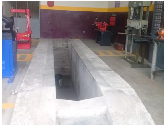
Figura 34. Bahía de mantenimiento 4
