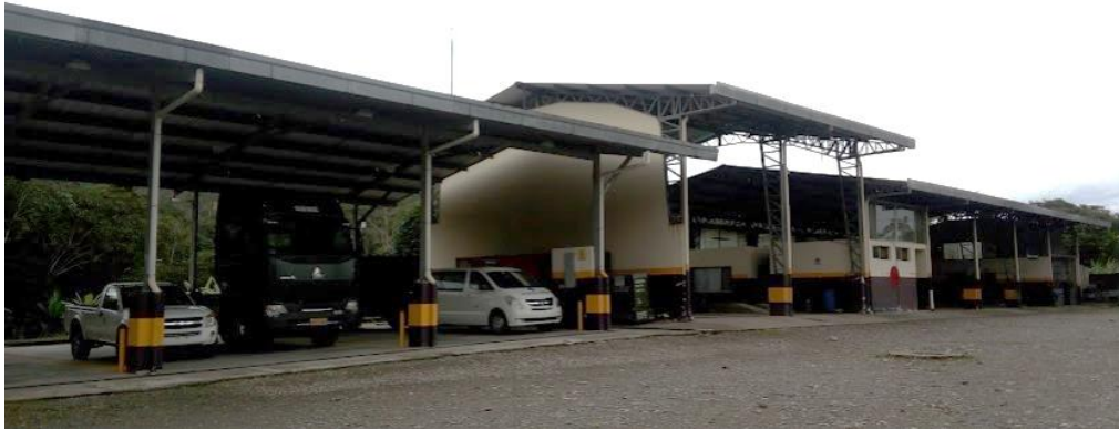
Figura 30. Infraestructura del taller de mantenimiento
