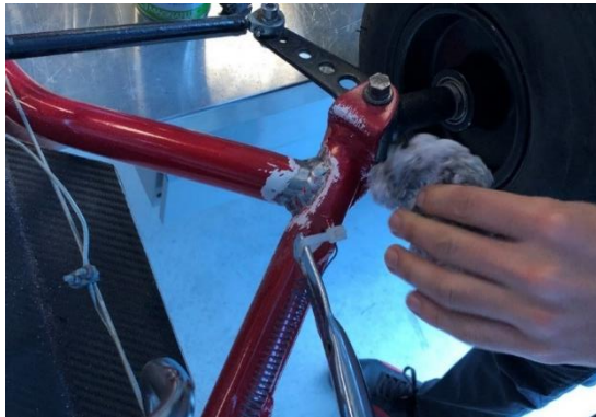
Figura 79. Acondicionamiento de la superficie.
