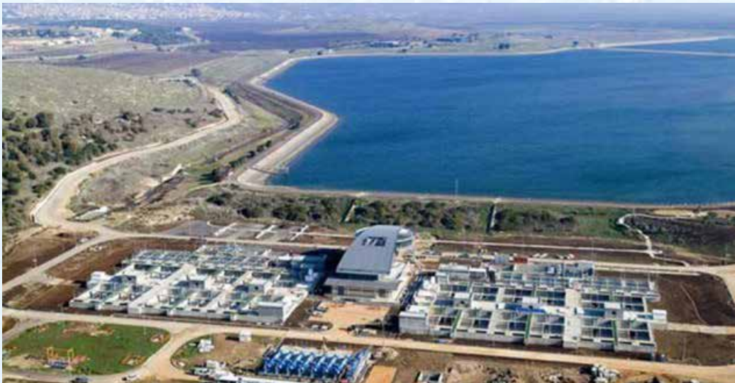
Figura 79. Planta Desalinizadora en Sorek, Israel Fuente . http://www.hidroconsulting.com.co
