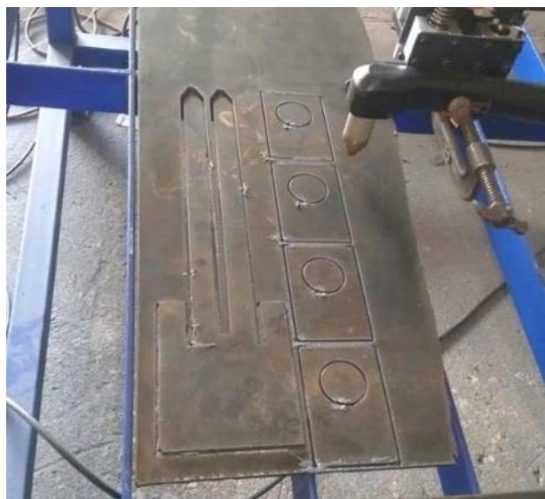
Figura 56. Construcción de las horquillas mediante corte por plasma
