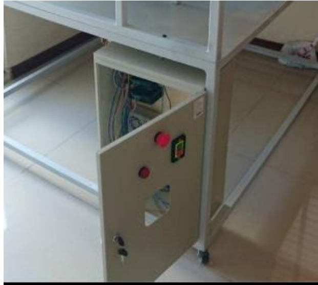
Figura 62. Instalación de la caja de control
