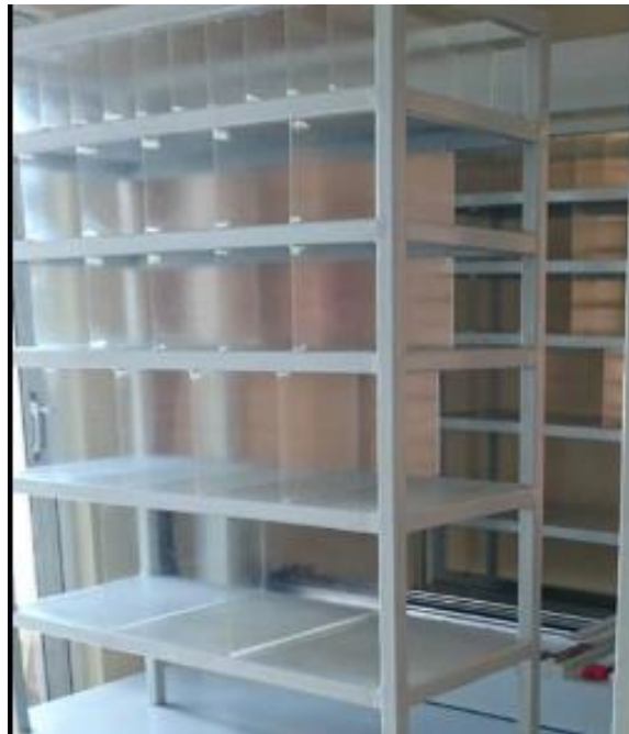
Figura 61. Instalación de planchas de acrílico
