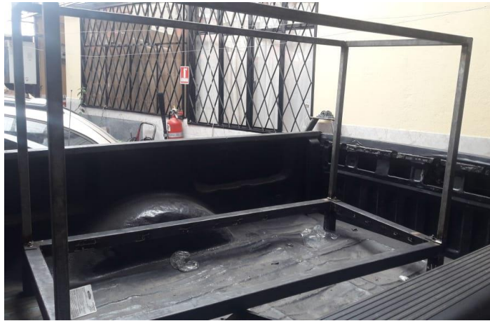
Figura. 25 Construcción de la estructura metálica de soporte
