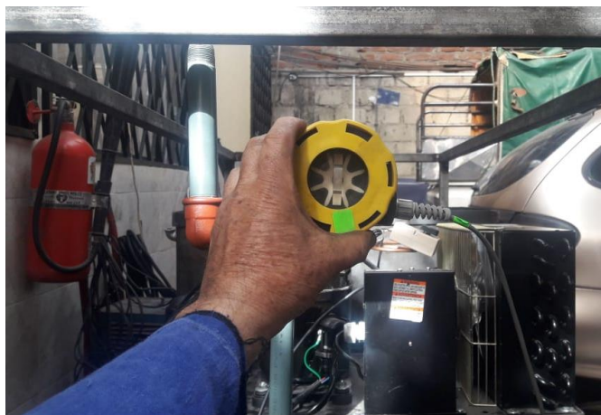
Figura. 30 Instalación de la instrumentación
