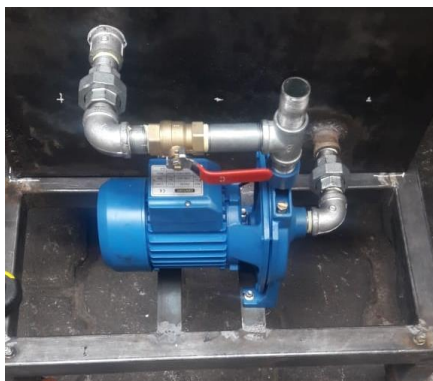
Figura. 27 Instalación de las bombas en los tanques
