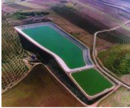
Figura 9.4 (Piscina Impermeabilizada)
