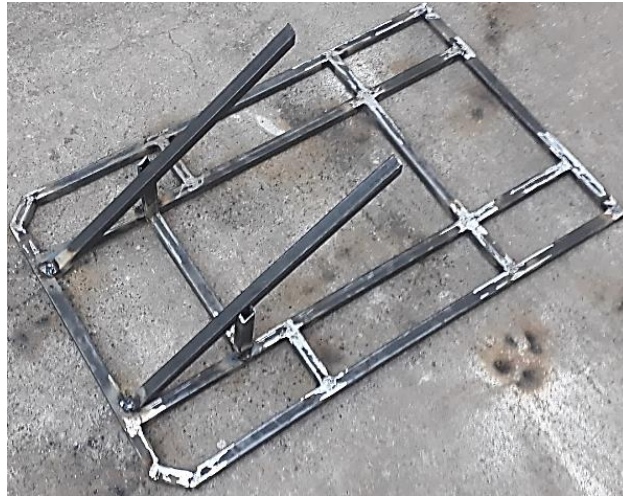
Figura 92. Soldadura base plataforma
