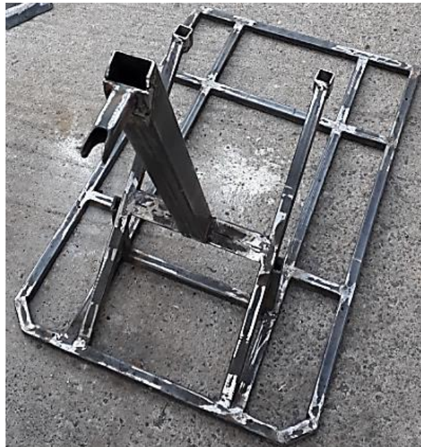
Figura 93. Soldadura estructura apoyo rodillas
