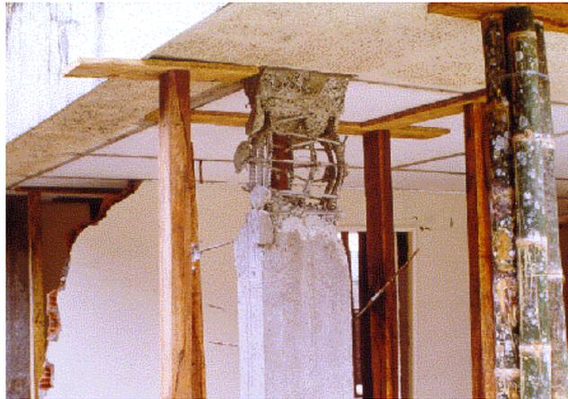
**Figura 1.4** Gran nivel de daño estructural en la planta baja del Edificio Los Corales
