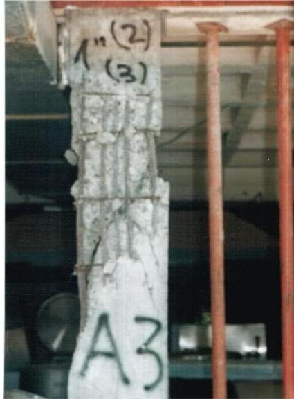
**Figura 1.6** Daño en la columna más afectada del Hospital Miguel H. Alcívar.
