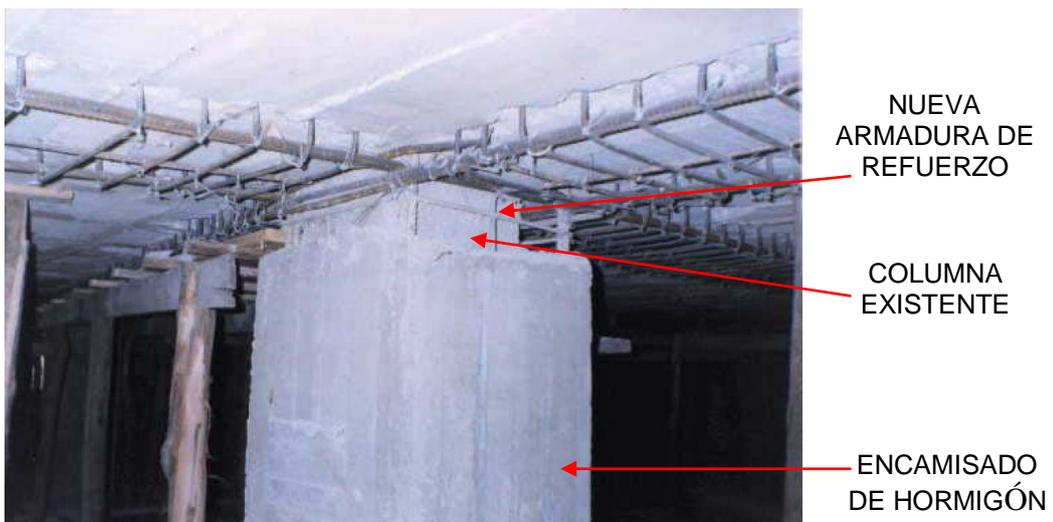
**Figura 1.9** Encamisado de hormigón en una columna del hospital Miguel H. Alcívar
