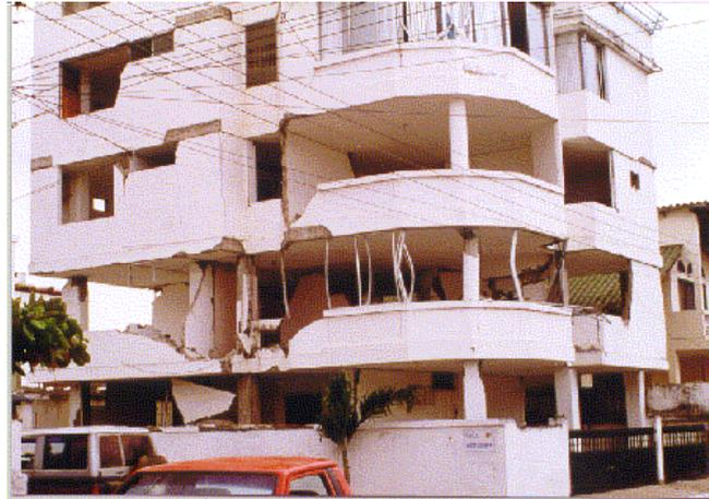
**Figura 1.3** Daños estructurales y arquitectónicos en el Edificio Karina
