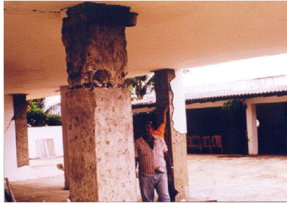
**Figura 1.5** Daño en junta de construcción en columna
