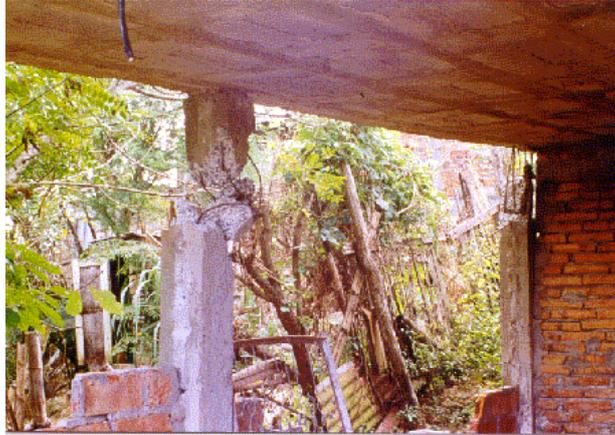
**Figura 1.1** Daño en edificaciones de hormigón armado en barrios marginales. Romo (1998)
