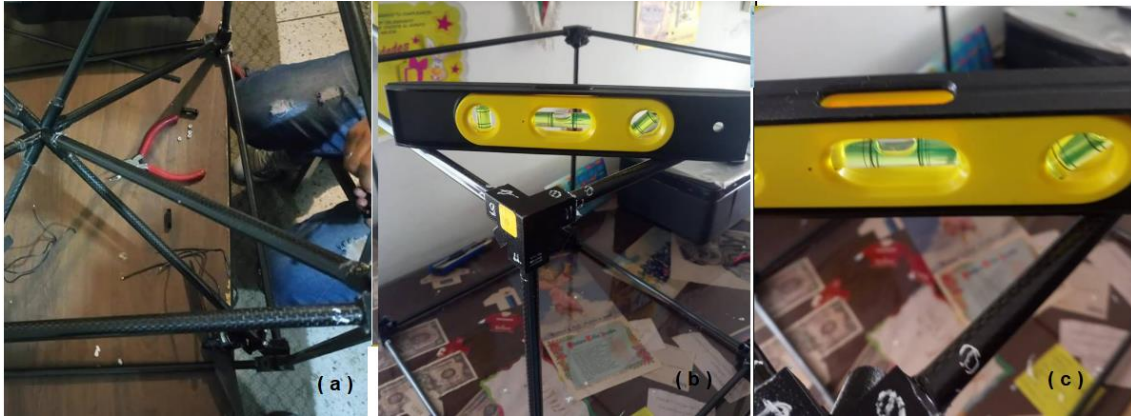
Figura 80. a) Unión con pegamento de las barras b) Verificación de nivel de las caras c) Inspección del nivel en todos los vértices.
