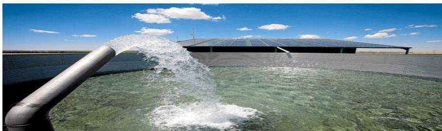
**Figura 6.** Sistema de bombeo solar de mediana potencia
