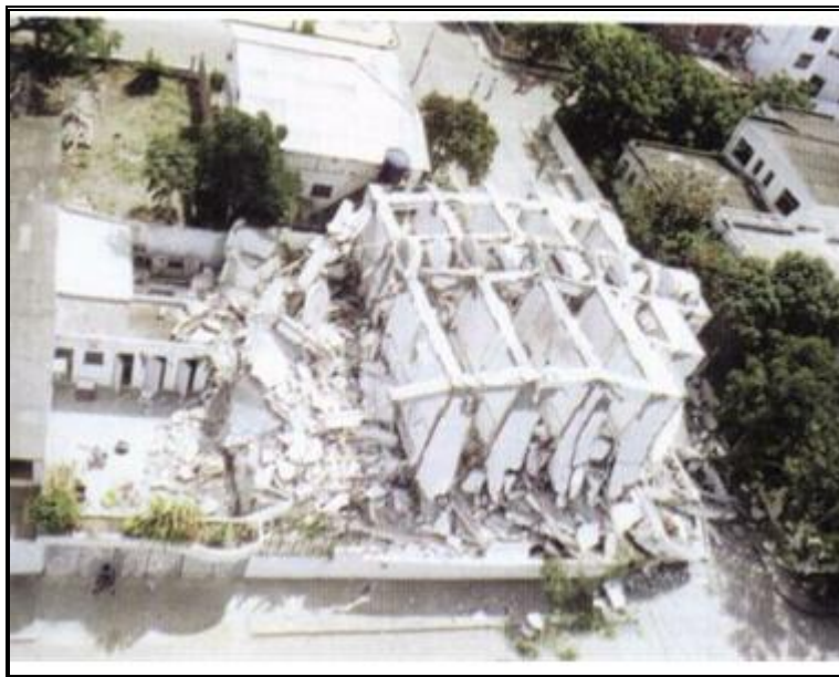
Figura 1.1. Edificio Calypso, sismo de Bahía de Caráquez
