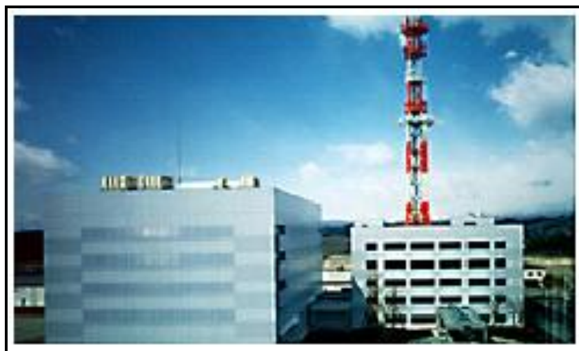
Figura 1.8 Tohoku Power Electrica Company, Japón
