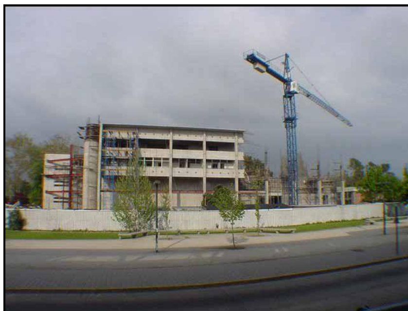
Figura 1.13 Construcción del Edificio San Agustín de la Facultad de Ingeniería de la Universidad Católica
