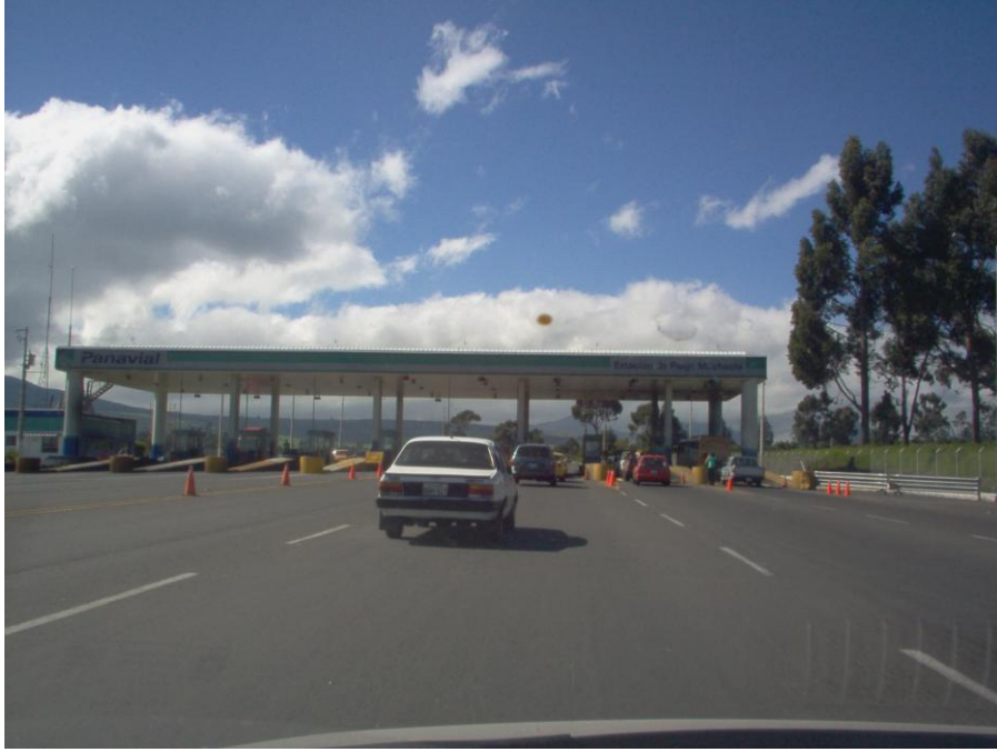
Figura 3.1: Estación de Peaje Machachi
