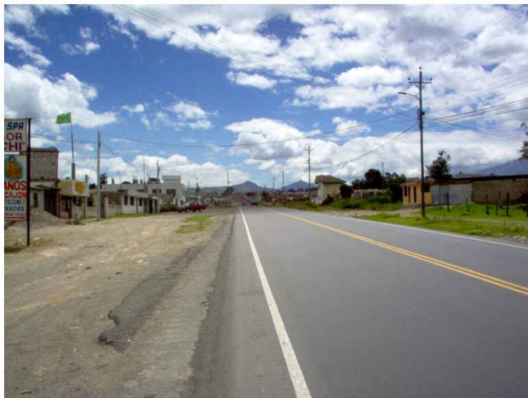
Figura 3.12: Visibilidad de la calzada de estación 1: sector La Avanzada.
