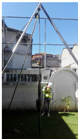
Figura 79 Equipo de penetración instalado en el patio posterior de la Casa de la Academia de la Lengua.
