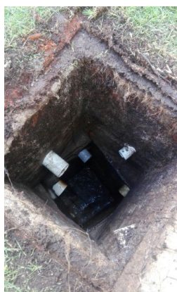
Figura 83 Caja de revisión o pozo séptico ubicado en el patio posterior de la Casa de la Academia de la Lengua
