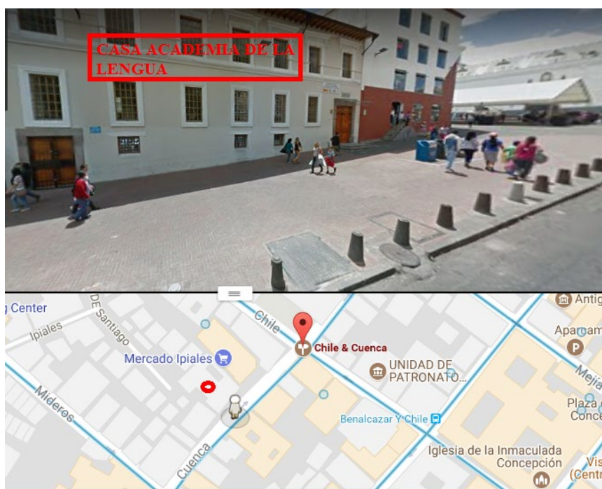
Figura 7 Ubicación de la estructura (Casa Academia de la Lengua)
