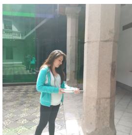
Figura 122 Ensayo de esclerometría en columna de piedra C7
