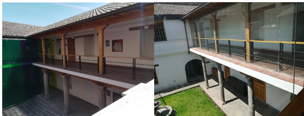
Figura 12 A la izquierda patio central y a la derecha patio posterior, en los cuales se observa la diferencia de material de las columnas, es decir planta baja piedra- planta alta madera.
