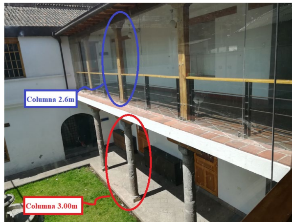
Figura 144 Columnas centrales en patio posterior.
