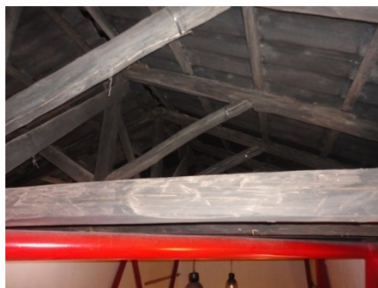
Figura 119 Cerchas de madera en cubierta
