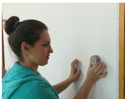
Figura 124 Refrendado en superficie, antes de esclerometría, pared adobe
