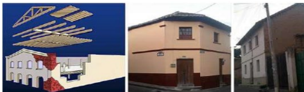
Figura 137 Tipo de sistema estructural: Mampostería sin refuerzo (URM)
