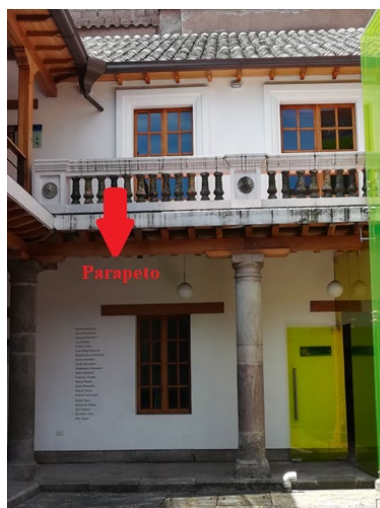
Figura 163 Elementos no estructurales en la estructura CAEL.
