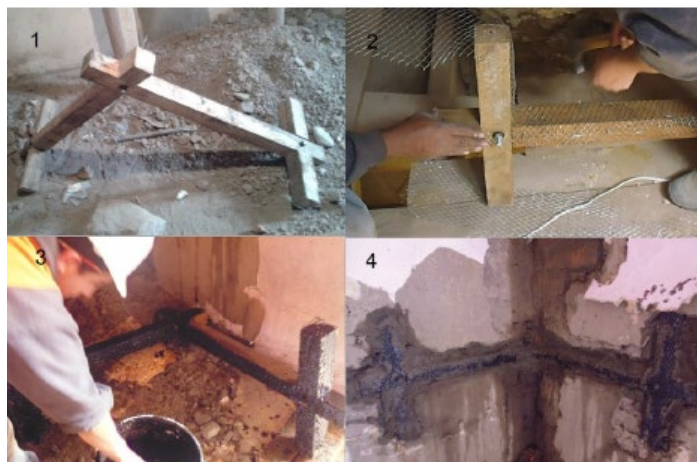
Figura 233 Elaboración y colocación de refuerzo tipo cocido con llave de madera Fuente: (Espinoza Larrea, 2017)
