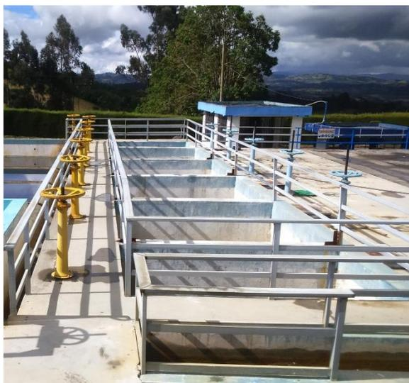
**Figura 15.** Fotografía de las compuertas en la etapa de Filtración
