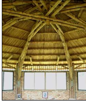
Figura 1.3 Construcciones en Bambú de Jörg Stamm
