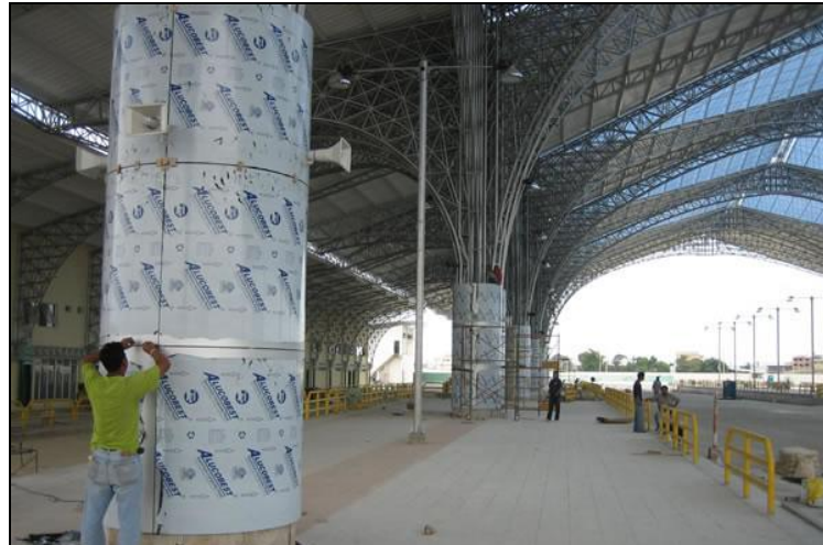
Figura 1.5 Estructura de Acero Ligera, Terminal río Daule
