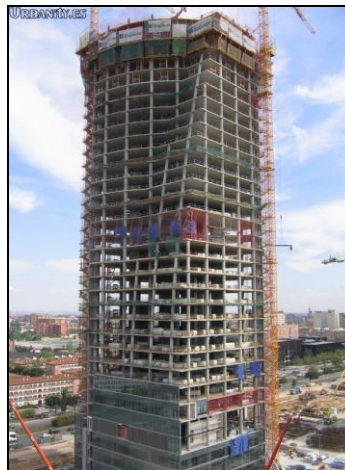
Figura 1.4 Estructura de Acero Pesada, Torres Madrid Arena
