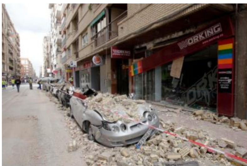
Figura 2 Pared de mampostería caída sobre autos Avenida Juan Carlos I de Lorca, después del terremoto del 2011
