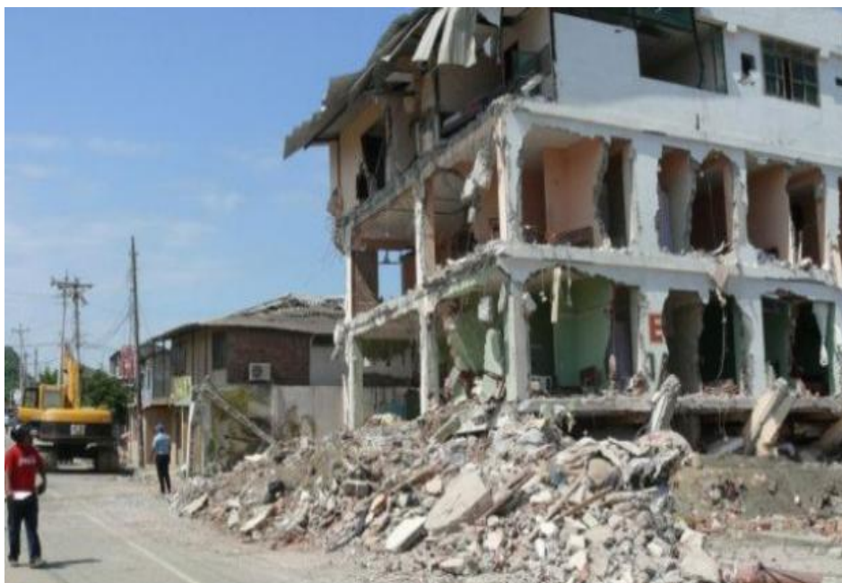
Figura 1 Pared de mampostería caída después del terremoto de abril del 2016
