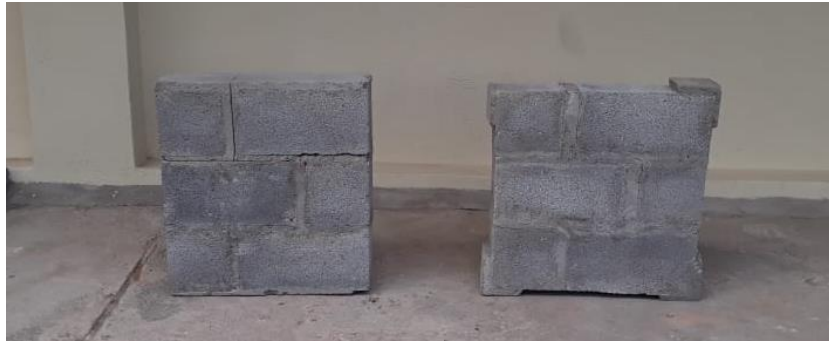
Figura 87 Paredes de bloque en intemperie
