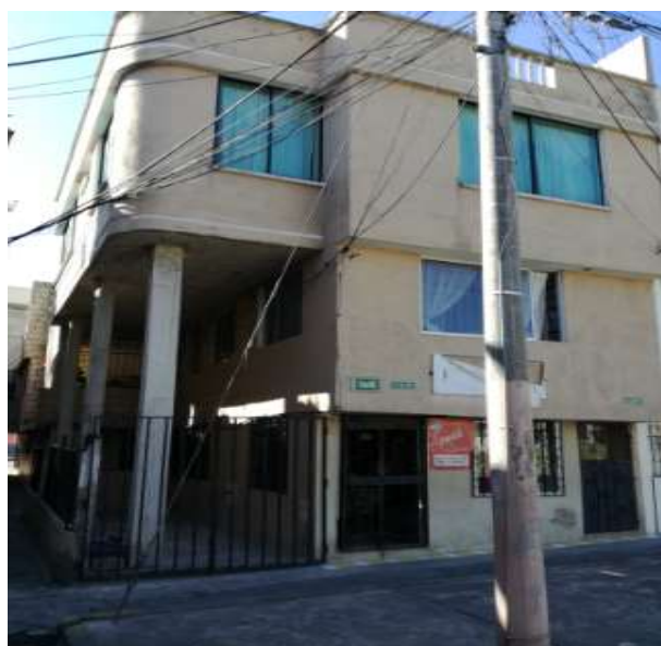
Figura 87. Fachada de la vivienda del Sr. Servio Guzmán Erazo
