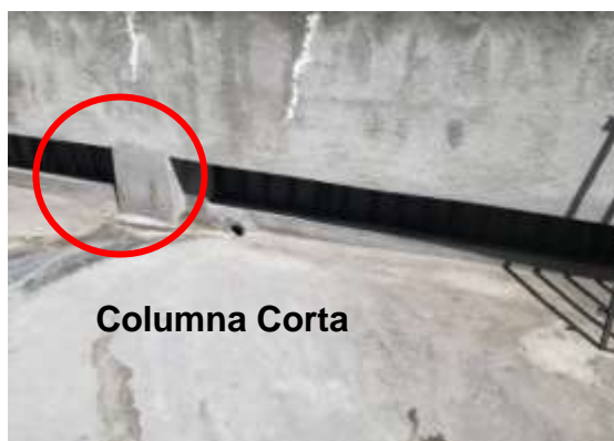
Figura 135 Columna corta vivienda Sr. Enrique Altamirano.
