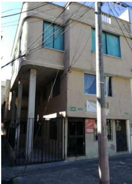
Figura 26. Fachada de la vivienda del Sr Servio Guzmán Erazo.
