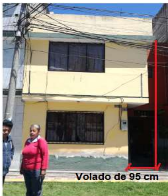
Figura 134. Volados sucesivos teniendo en total 95 cm en el último piso en la vivienda del Sr. Nelson Guzmán.
