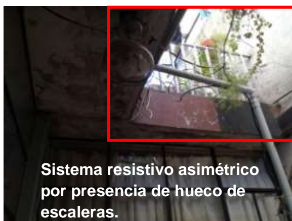
Figura 74 Irregularidad torsional en la vivienda de la Sra. Marlene Campos.
