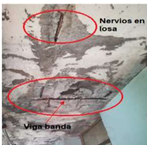
Figura 112 Humedad por filtración en la vivienda del Sr. Diógenes Varela.
