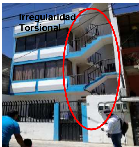
Figura 124 Irregularidad torsional vivienda Sr. Oswaldo Cruz.
