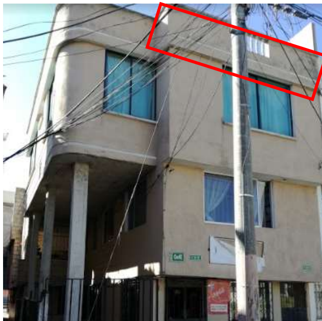
Figura 34. Parapetos en la fachada de la vivienda del Sr. Servio Guzmán Erazo.
