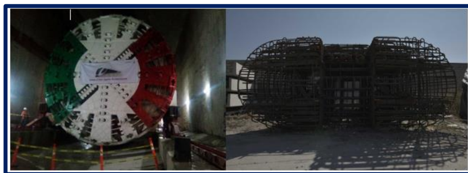
Figura 4. Túnel Tren ligero Guadalajara- México
