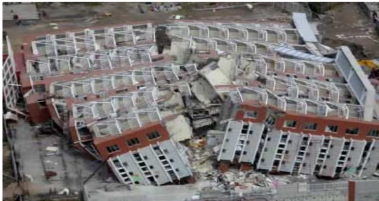
Figura 4: Falla catastrófica del edificio Alto Río en Chile Fuente: (Ávila, 2010)
