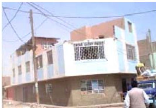
Figura 4.11 Edificio esquinero afectado por el sismo en Ica 21
