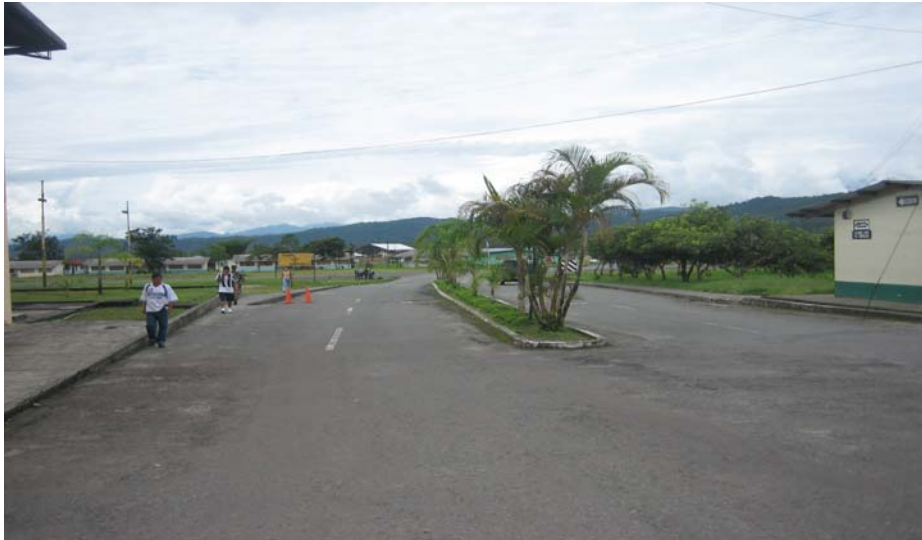
Figura 2.2: (Acceso de entrada al Paso Deprimido)
