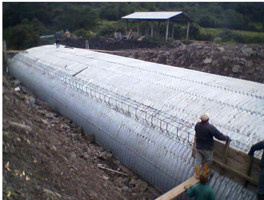
Figura 4.24: (Estructura metálica súper luz tipo elipse)
