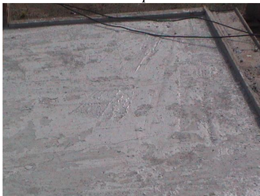
Foto N° 20: Contrapiso Fisurado
