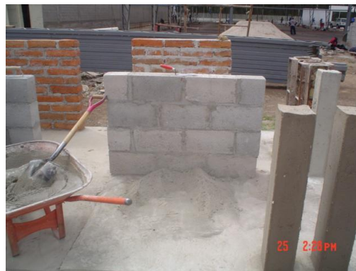
Foto N° 24: Vista de Mampostería Levantada
