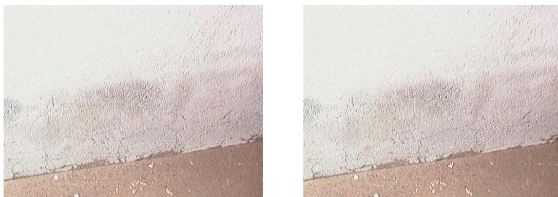
Foto N° 26: Mampostería enlucida con Arena de Pomasqui
