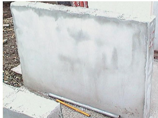
Foto N° 28: Mampostería enlucida con Enlumax de Intaco (Ligera humedad y presencia de microfisuras)
