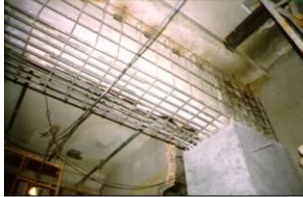
Figura N° 24: Refuerzos de Hormigón
