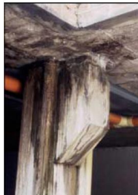
Figura N° 17: Vista de cabeza de columna.
