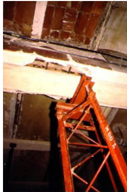
Figura N° 19: Trabajos de apuntalamiento
