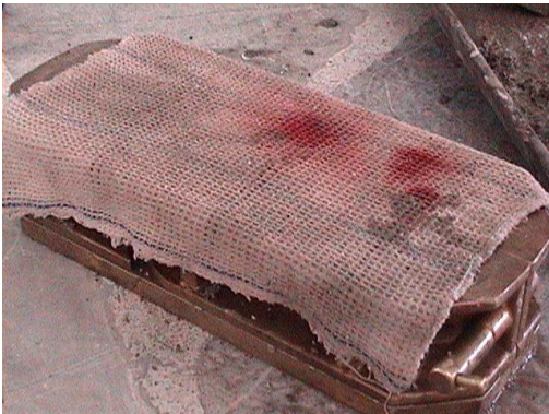
Foto N° 14: Cubriendo a los Morteros para conservar su humedad
