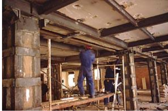
Figura N° 25: Sustitución funcional de estructuras de hormigón
