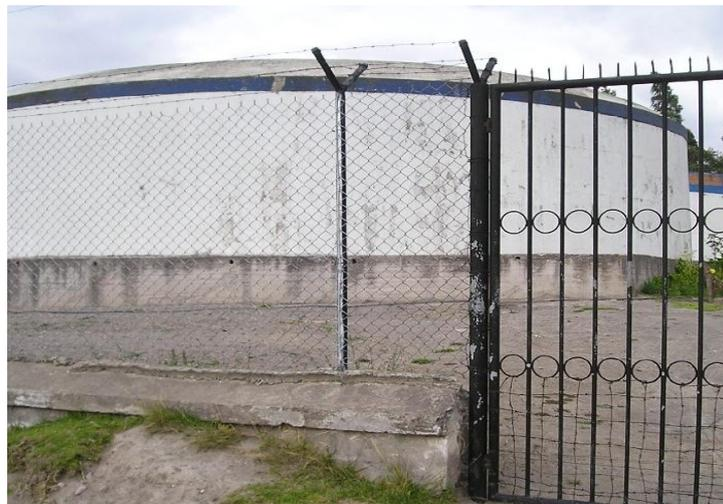
**Foto 2.4: Tanque de reserva en mal estado**
