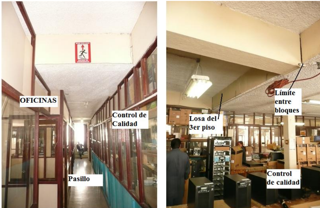
Pasillo y Control de Calidad
