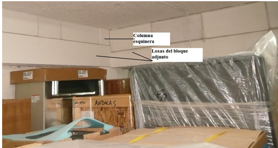
Losas del bloque adjunto
