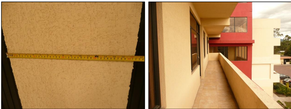
Columna y balcón del Piso 4.
