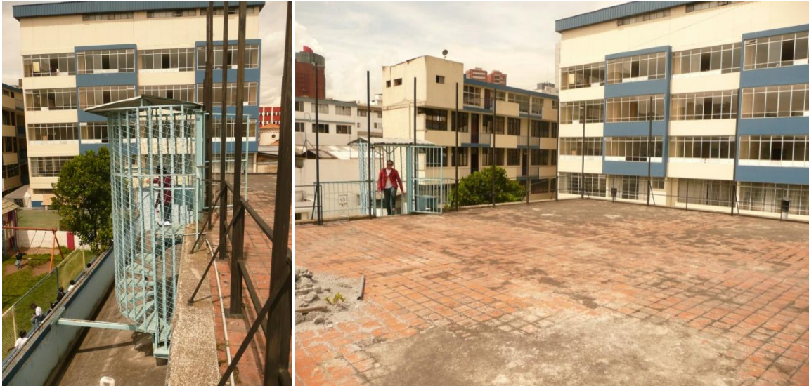
Escalera de Terraza y Vista general
