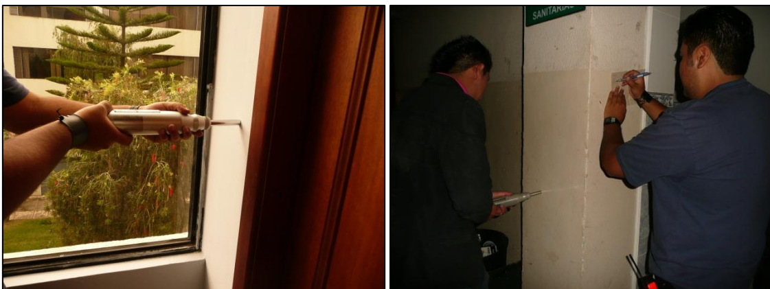
Uso del esclerómetro en Piso 3 y Piso 2.
