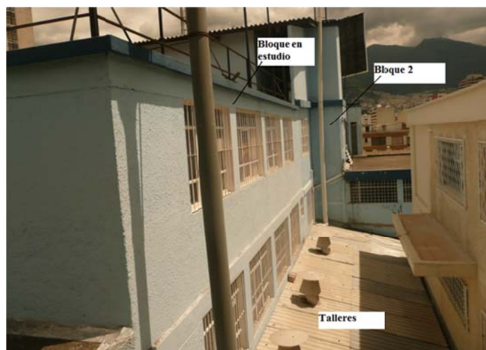
Figura 5.2 Vista del Bloque Estructural en estudio.
