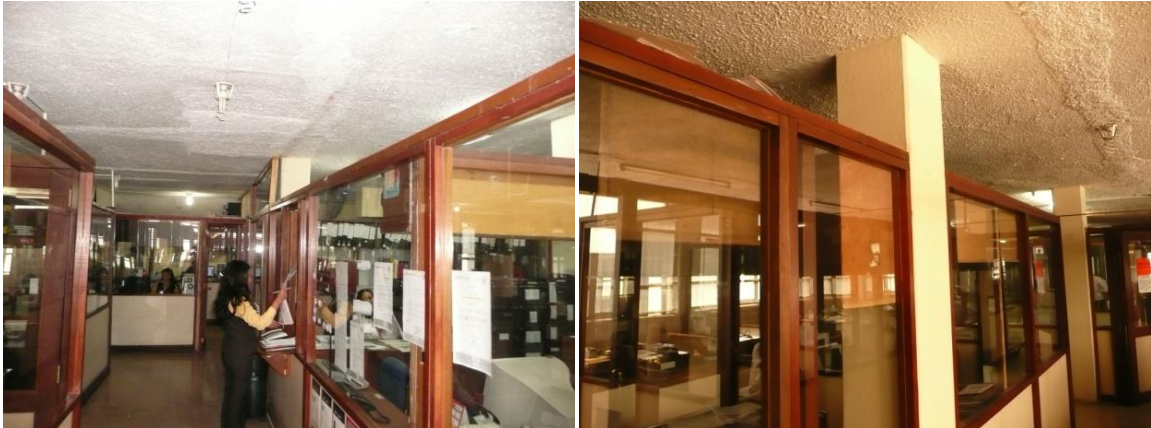
Oficinas, Corredor y Columnas
