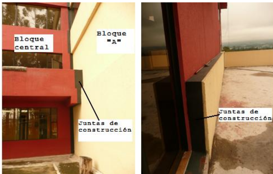
Figura 4.3 Juntas de Construcción, Edificio “Residencia” – ESPE.
