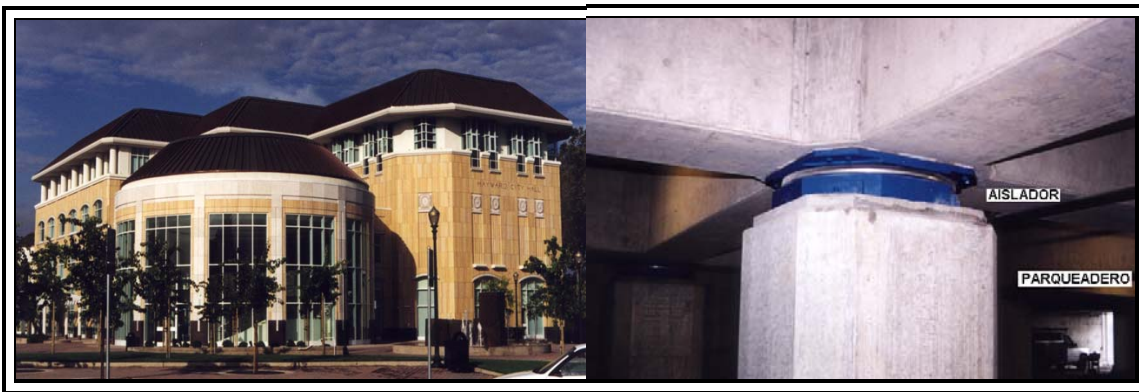
Figura 1.3: Edificio, Hayward City Hall, con aisladores FPS.
