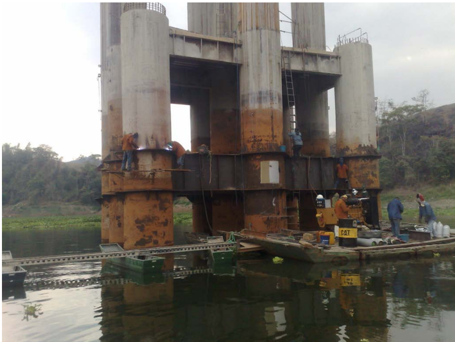
Figura 3.3 Construcción actual del puente Carrizal.
