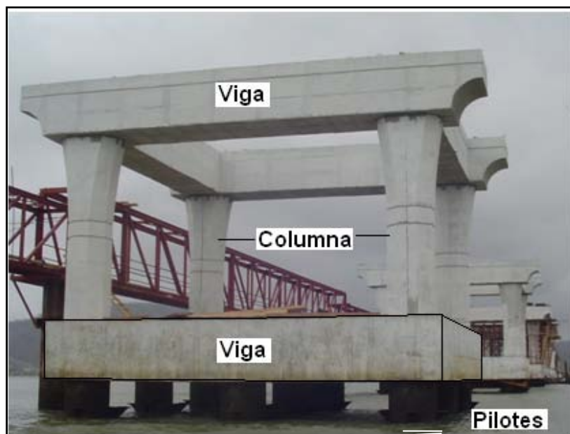
Figura 4. 1: Elementos que conforman los apoyos del puente.
