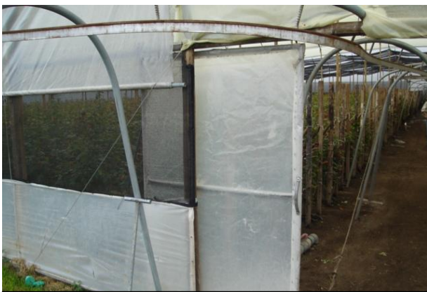
Fotografía 3. 10 Ancho de Nave
