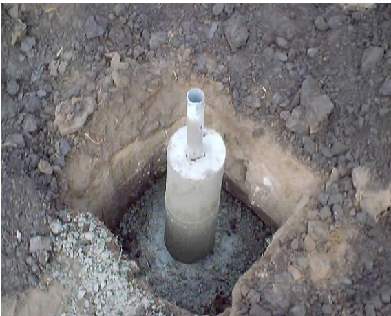
Fotografía 3. 6 Micropilote de Invernadero
