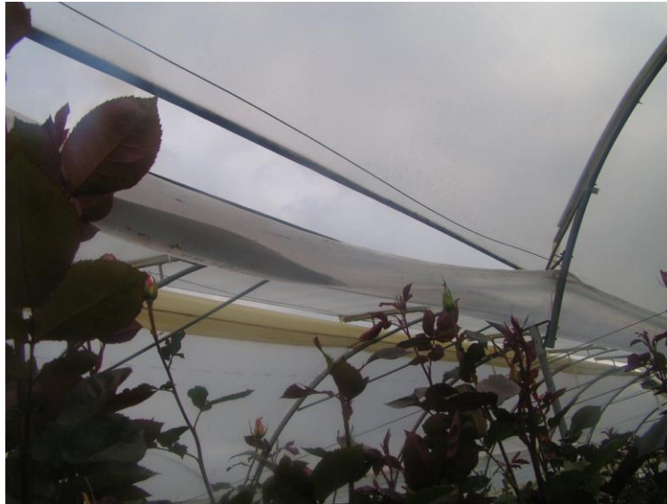
Fotografía 4.2 Deformación de los canales por el granizo
