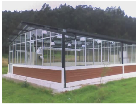
Fotografía 6.4 Invernadero de Vidrio del IASA
