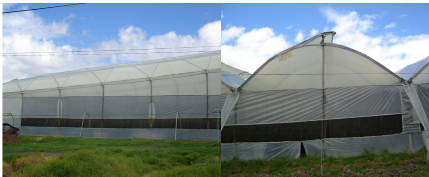
Fotografía 1.14 Vista lateral y de culata de un invernadero
