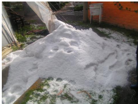
Fotografía 6.3 Granizo desalajado por los canales
