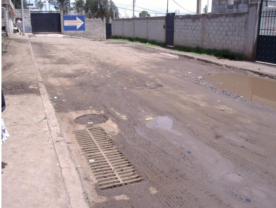
DESAGUES DE AGUA LLUVIA EN LA PARADA INICIAL BUENOS AIRES
