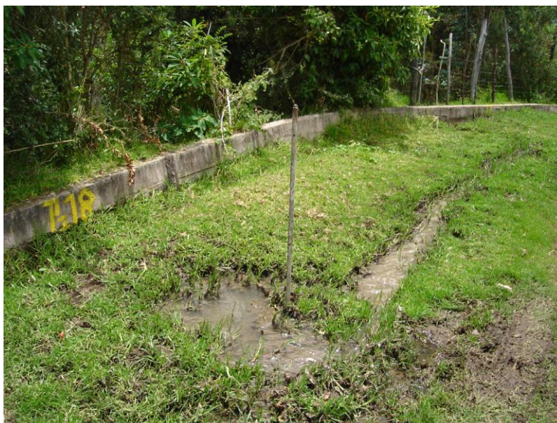
Figura 1.4: Alcantarilla colapsada
