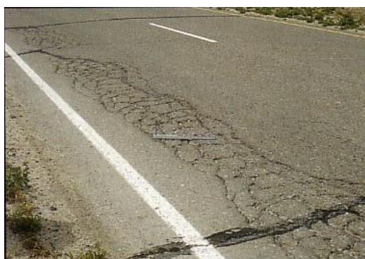
Fig 2. 3 Fatiga en la zona de paso de cargas, la huella.
