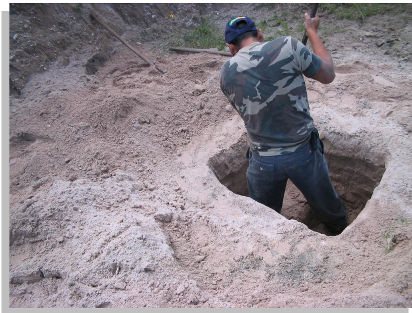
Foto No.4.1: Excavación de calicata en la abscisa 1+500.
