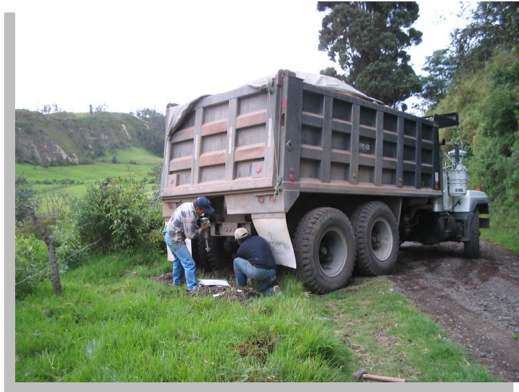
Foto No.4.4: Vista del vehículo que sirve de contra peso para CBR “in situ”.
