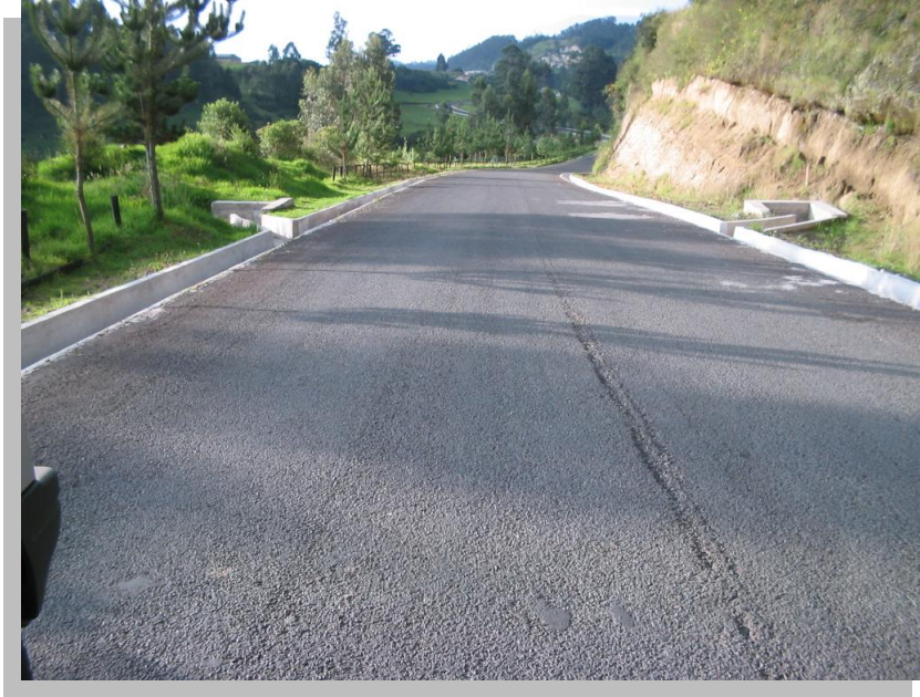
Foto No.1.8. Vía de Acceso al IASA.
