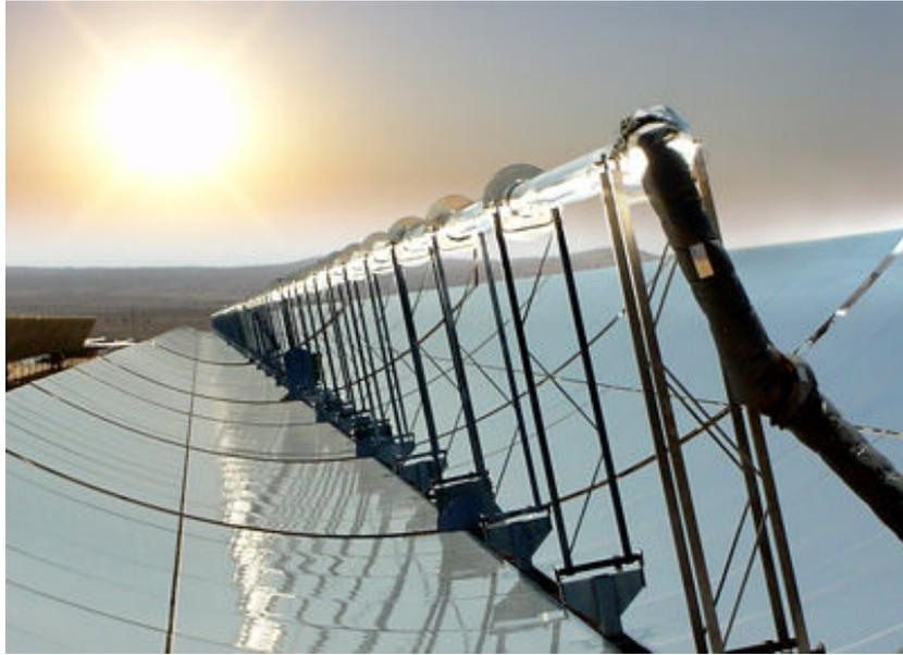
**Figura 3.2.** Tubo absorbente en concentrador<sup>6</sup>
