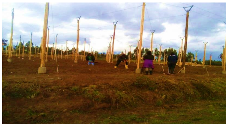
Figura 46. Trabajadores preparando el terreno
