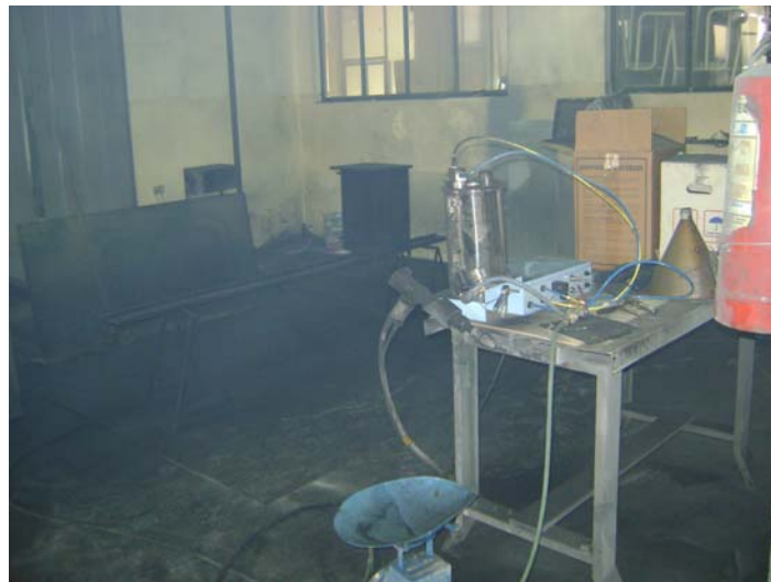
IMAGEN 2.2 Bodega de Pintura.
