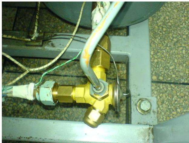
**Fig. 4.3** Válvula de expansión calibrada.
