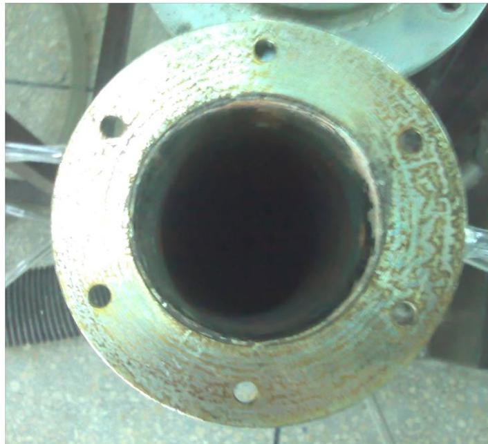
**Figura 5.23 Breda y ducto de aire**
