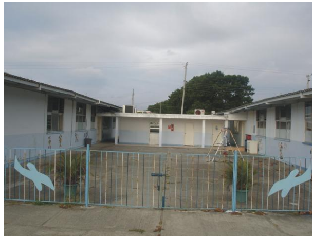
Fotografía No. 5. 2 PATIO PRINCIPAL DEL CENTRO INFANTIL
