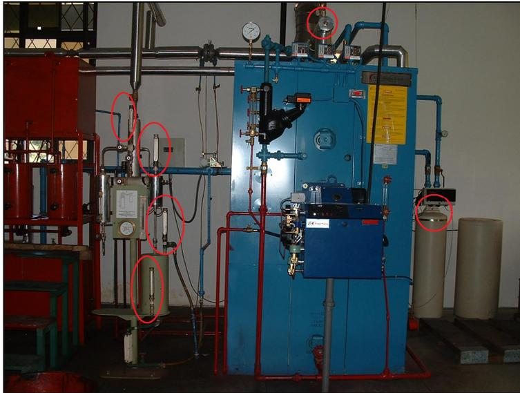
**FIGURA 3.3** Ubicación de los sensores de temperatura.
