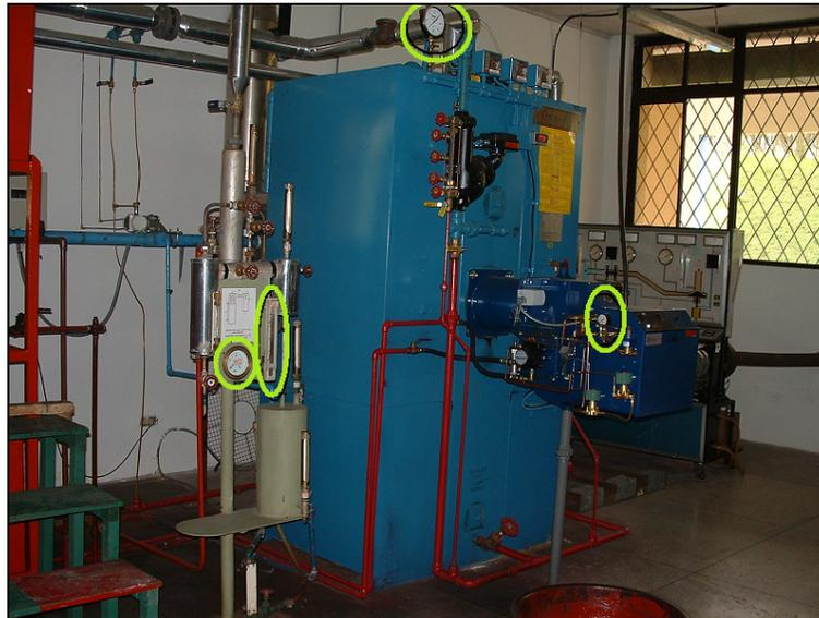
**FIGURA 3.4** Ubicación de los sensores de presión.
