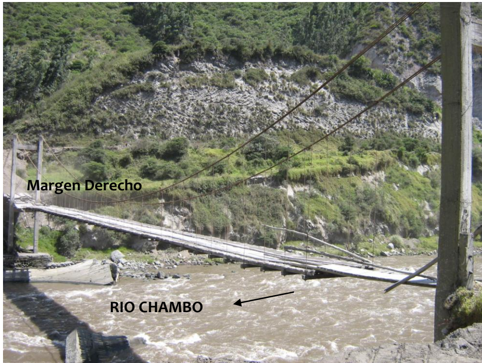
Foto No 13: Abscisa 0+190 – 0+250 : Vista General del sitio de cruce del proyecto sobre el río Chambo.
