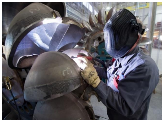
Figura 12. Reparación de las paletas de una turbina mediante proceso de soldadura GTAW Fuente: (Hydro Expolitation)
