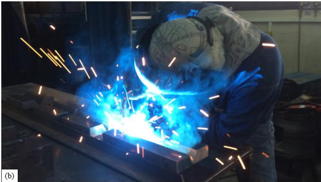
Figura 34. Control y soldeo de los ensamblés. (a) Equipos usados para el control de las variables de soldadura (Pinza amperimétrica, termómetro laser, multímetro). (b) Proceso de soldeo de los ensamblés mediante proceso de soldadura GMAW
