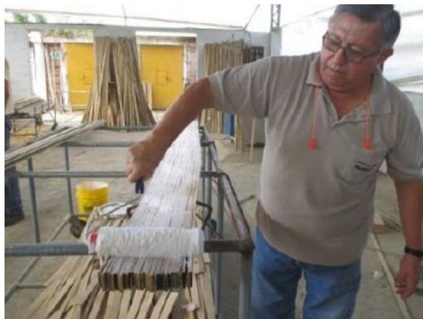
**Figura 28** Armado y encolado de laminados
