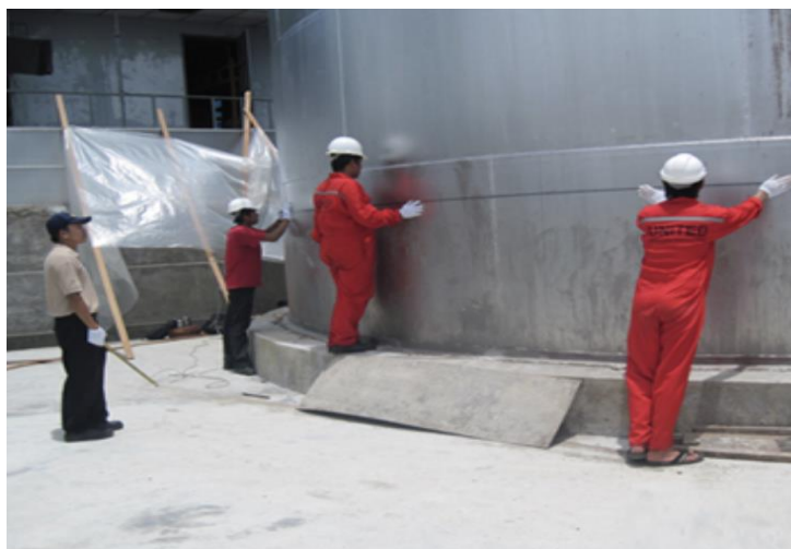
Figura 18. Encintado de Tanque Vertical
