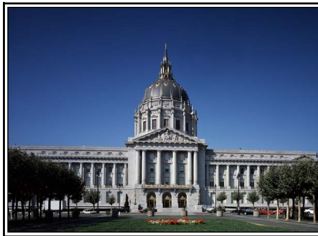
Figura 1.7: San Francisco City Hall, California, USA. 530 aisladores elastoméricos con corazón de plomo
